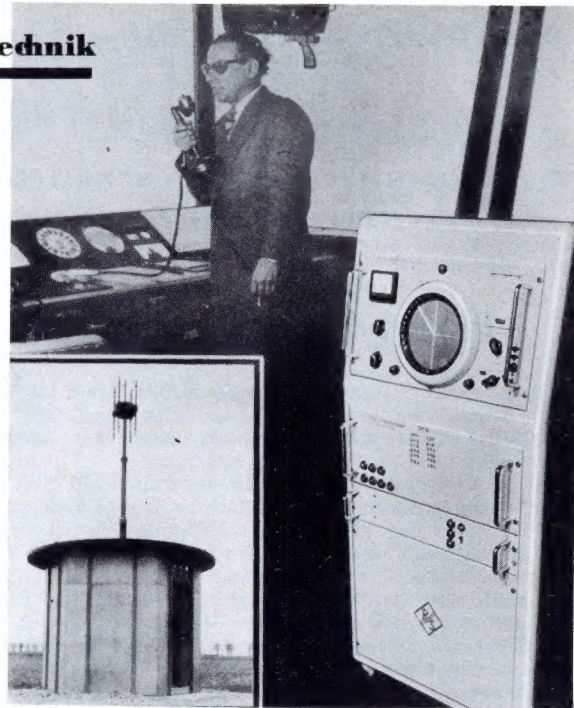
Das Innere der Peilstelle auf dem Flughafen München-Riem. Rechts der Gerätesatz, links Außenansicht des Peilhauses
